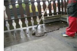
Dann wird sofort in die nasse Grundsicht unser Vlies eingerollt und blasenfrei angedrückt. Durch die vollflächige Acryl- Vlies- Einbettung wird eine zusätzliche Verstärkung und eine Schichtstärken-Kontrolle erreicht.
