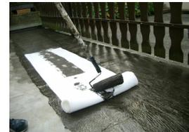
Am darauf folgenden Tag wird die Deckschicht ebenfalls mit Gummiwischern und Fellrollen gleichmäßig aufgetragen. Verbrauch bei der Deckschicht mindestens ca. 1- 1,5 kg/m<sup>2</sup>.
